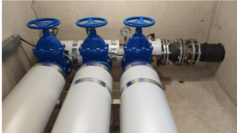
Zdjęcie nr 3: 3 pompy głębinowe w podziemnej komorze na sieci wodociągowej (Wodociąg Radomicko)
