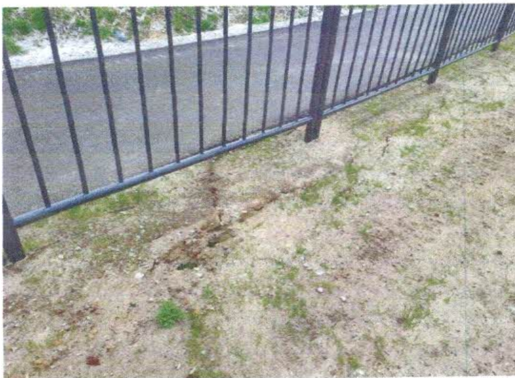
Fot. 11: Osiadanie pobocza (widok w kierunku Osiecznej)
