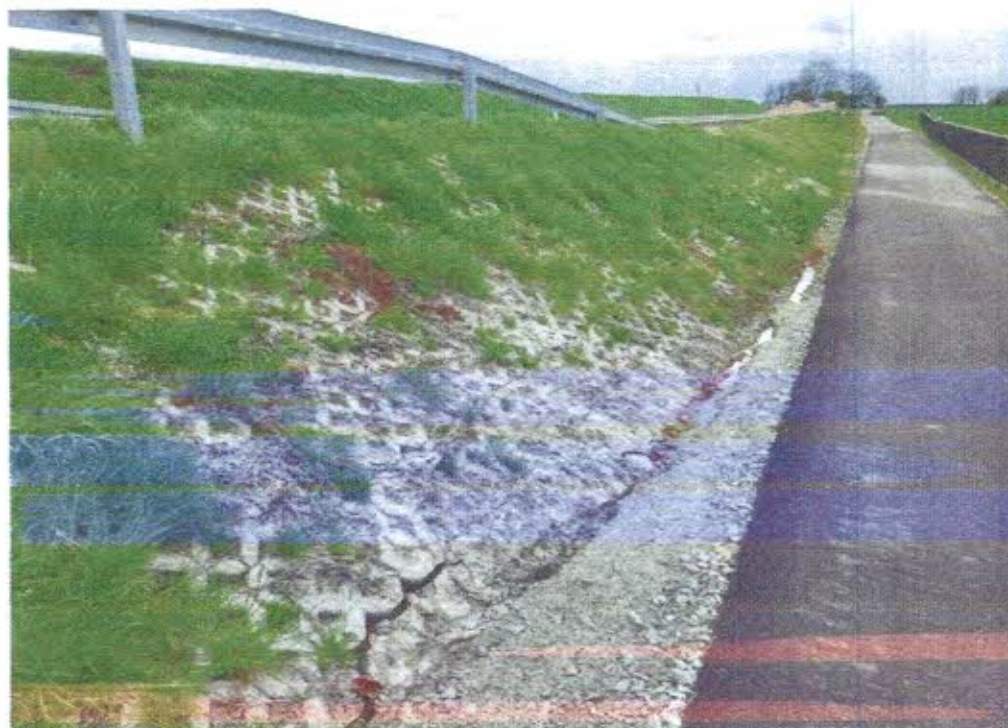
Fot. 10: Osiadanie pobocza (widok w kierunku Osiecznej)
